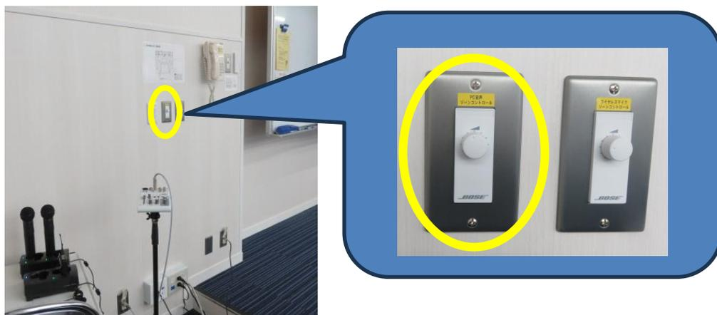
①HDMI 接続の場合、プロジェクターから流れる音量は、講義室前側の壁に設置されているダイヤルで調節できます。
